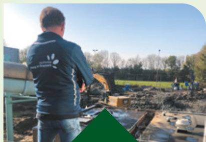
Hoofd TD Richard Broekhuizen kijkt vanaf het dak naar de sloop van het buitenbad en het kantoor van de technische ruimte.
